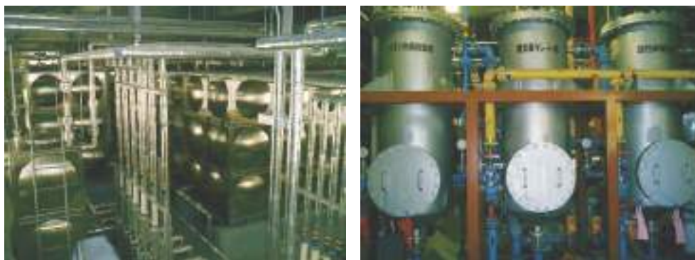
アイソトープ総合部門にある貯留槽（左）と浄化設備（右）
