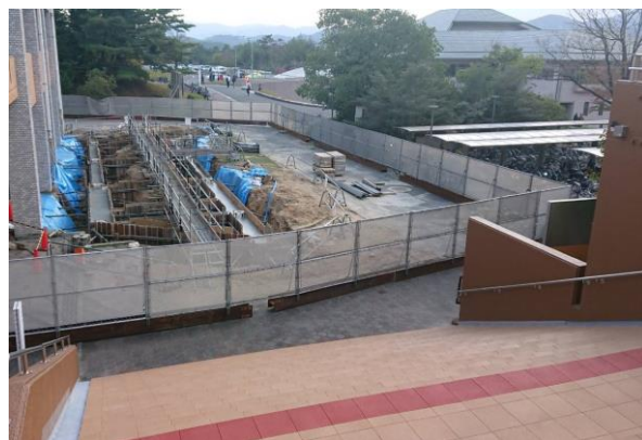
図2 東図書館横の工事現場
