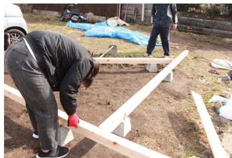
小屋施工の様子
