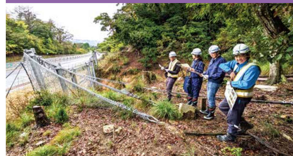
被災箇所復旧状況調査(広島県山県郡北広島町)
