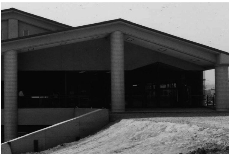
▲整備途中の西2食堂前
