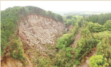
崩落している砂防ダム上流
