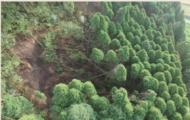
出の口集落北側斜面亀裂(2016.04.21撮影)
