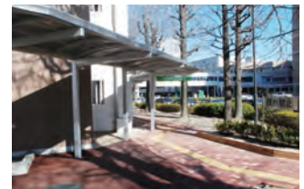
完成した屋根付きの歩行者専用通路
