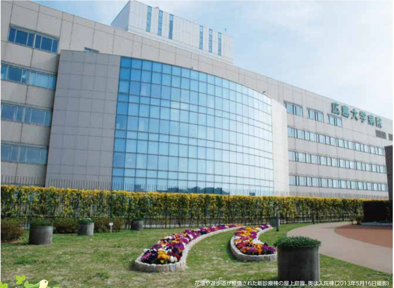
花壇や遊歩道が整備された新診療棟の屋上庭園。奥は入院棟(2013年5月16日撮影)
