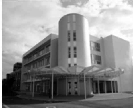
【学生プラザ外観】 正面の円柱部分はらせん階段で、外装もシンプルな物になっている。
