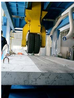
床板の移動載荷装置
