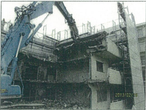
中層建物解体作業
