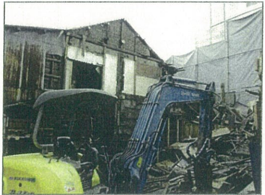
木造建物解体作業
