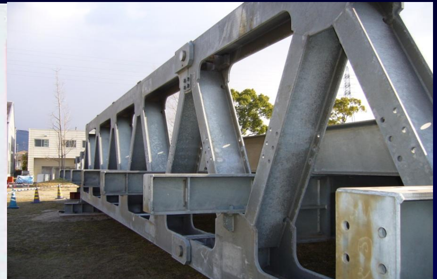
③手延べ機による送り出し架設
