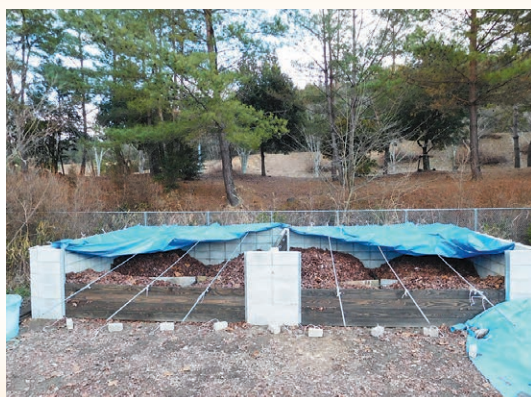
設置した堆肥場
