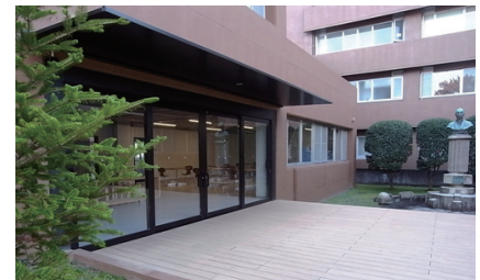
改修後の外観
