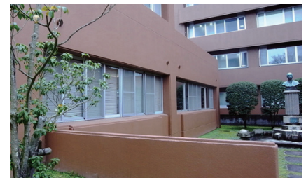
改修前の外観
