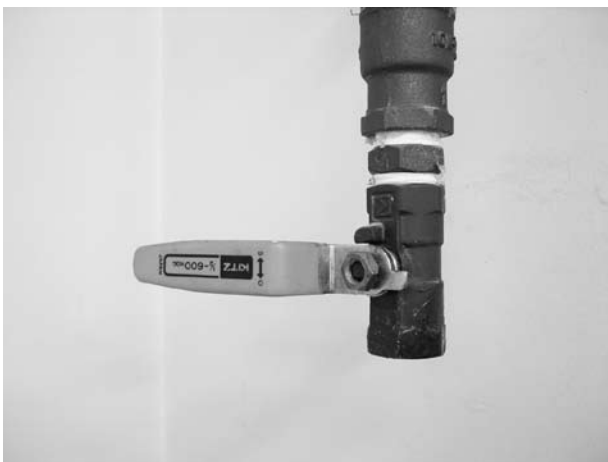
図6. バルブハンドル取りはずし前
