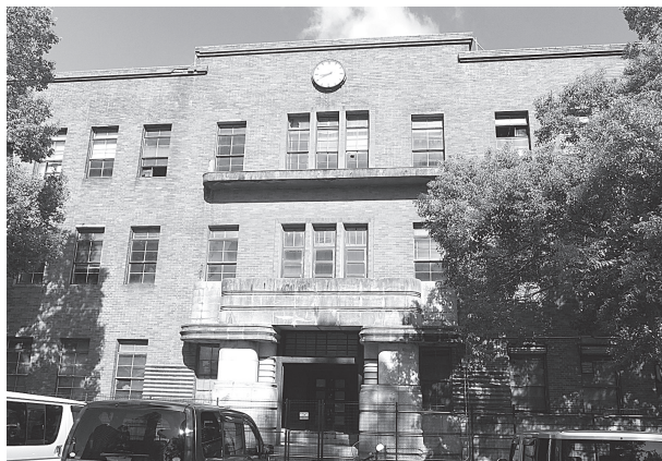
広島大学旧理学部1号館（被爆建物）
