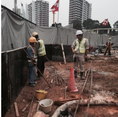
写真5-型枠組み立て段階
