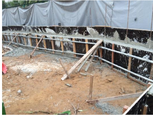
写真6-コンクリート打設後
