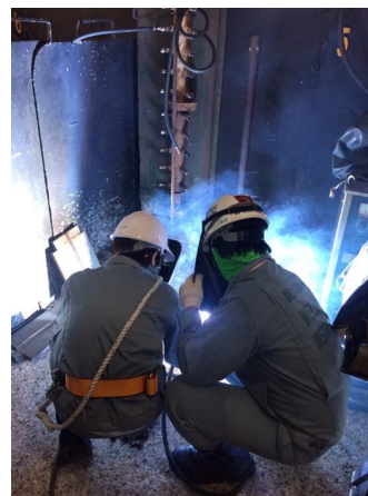
Fig.3 溶接実習の様子
