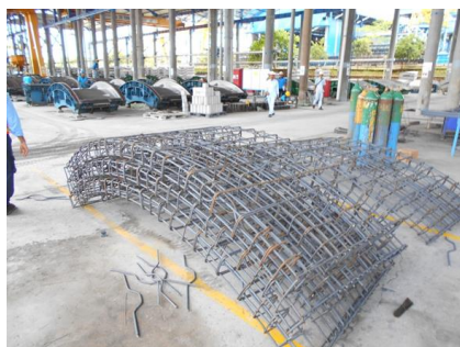
図 3-1 セグメントの鉄筋組立
