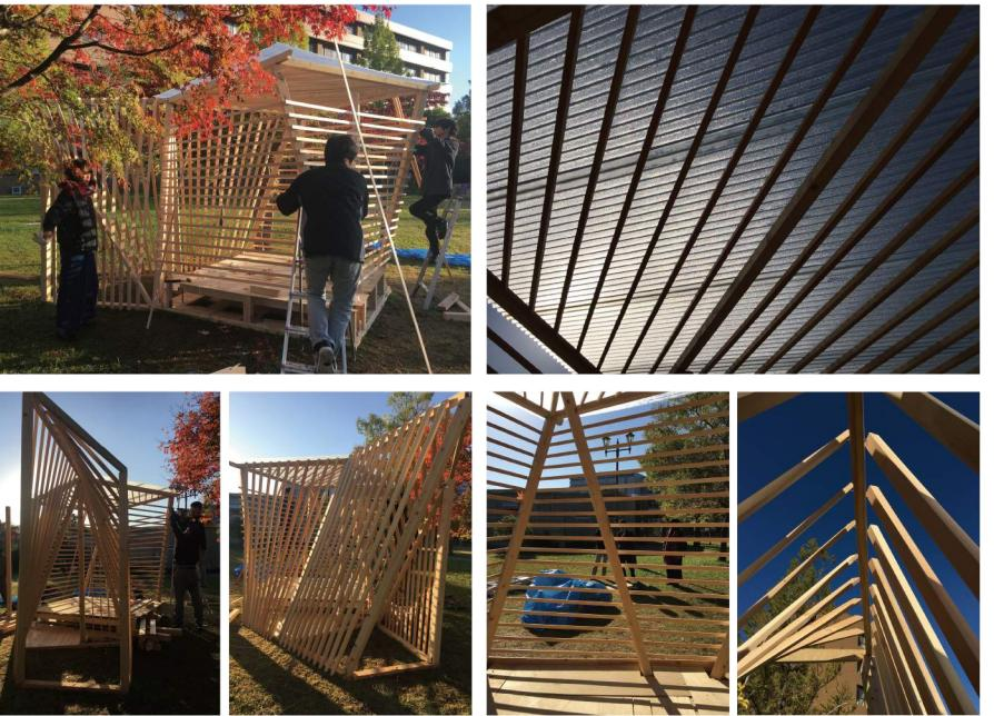
茶室の横格子の仕上げを行い、雨をしのぐために屋根は軽い素材を使用し、斜めの柱を支えていた仮柱を撤去し、ようやく茶室の形が見えてきた。
