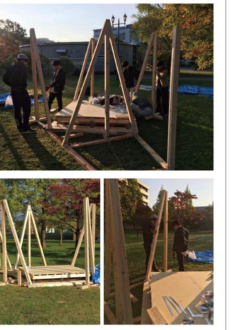
斜めの柱を支えるために仮の柱を建て、柱を安定させた。
