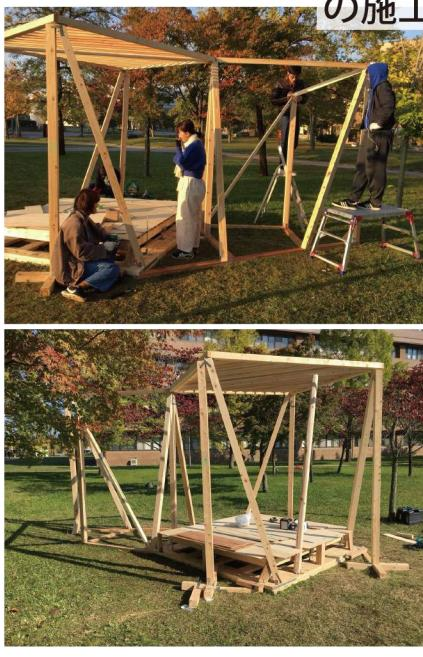
斜めの柱が自立するように柱の下部を補強し、露地入口のフレームを仕上げ行なった。
