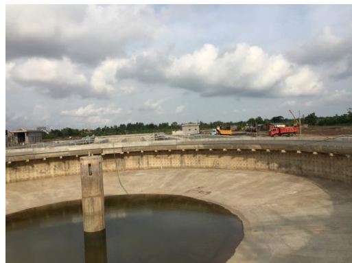
図-5.8 建設途中の下水処理場
