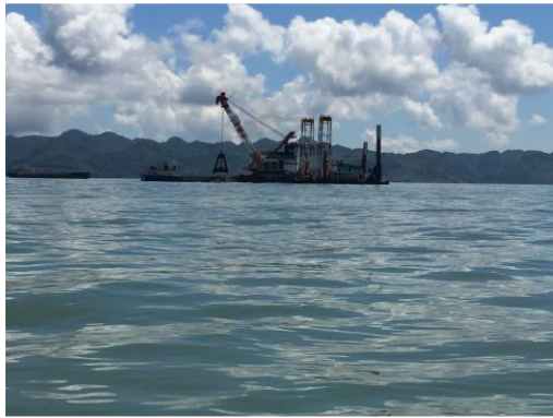
図-5.5 浚渫エリアにて掘削を行う浚渫船
