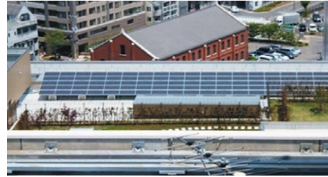
診療棟屋上設置状況（30kW）
