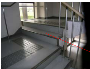
袖などが引っかからないよう端部が折り曲げられている
