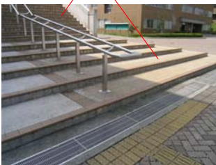
同一階段で踏面の長さが異なり歩きにくい
