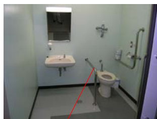
手摺が固定されており腰掛けにくい
