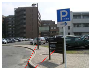
歩道上に障害物が有り歩きにくい
