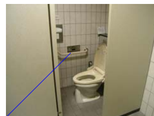
身障者・高齢者等の使用を考慮し一般便所にも手摺を設置
