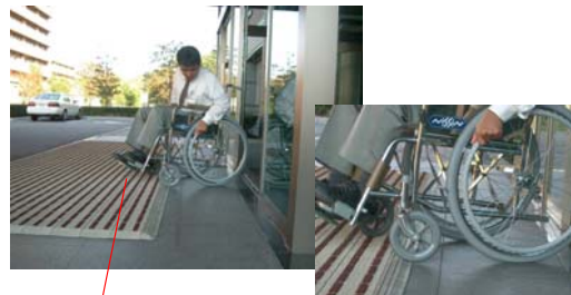
沓拭きマットは車いすの 通行の妨げとなる
